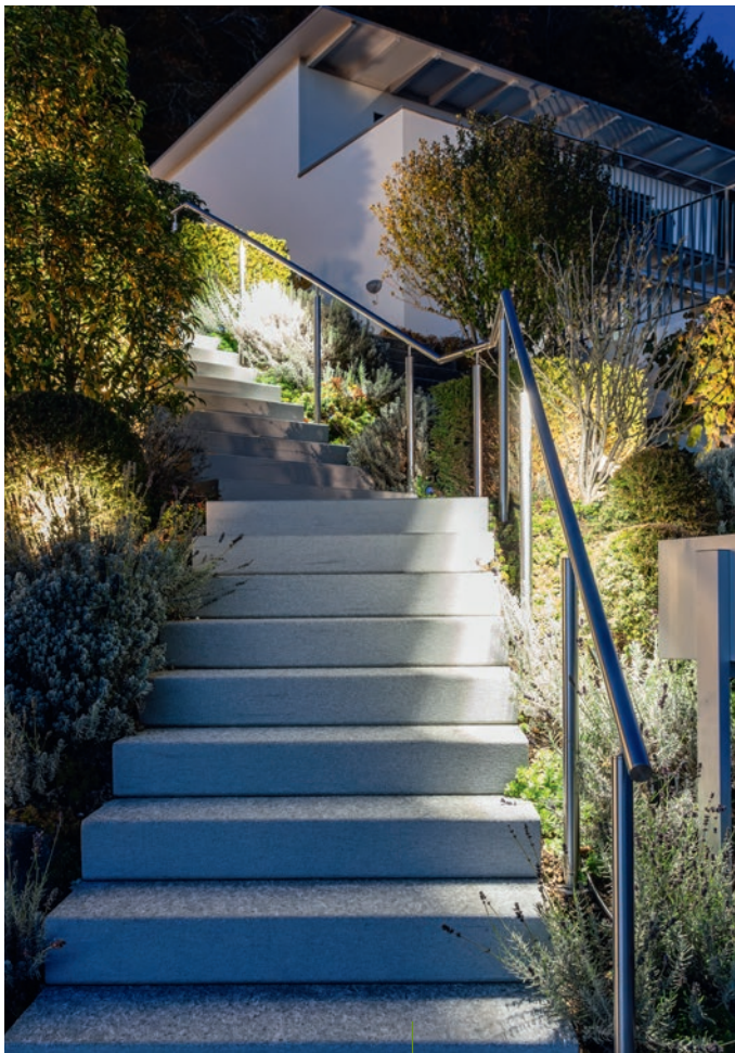
Edelstahl Handlauf, beleuchtet
