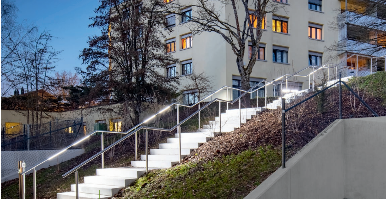
Edelstahl Handlauf, beleuchtet
