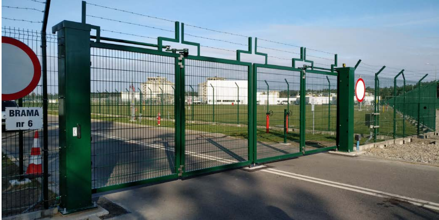
Trackless Speedgate mit Stacheldraht, installiert von Szymkowiak, Polen
