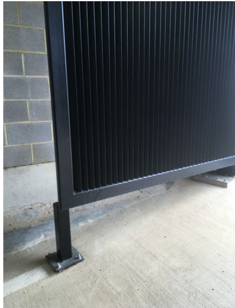
Schleifgefahr. Jemand, der fällt (nach dem Aufprall des Flügels), kann mitgeschliffen werden, bis er eingeklemmt wird, wegen der sich verengenden Bodenfreiheit.
