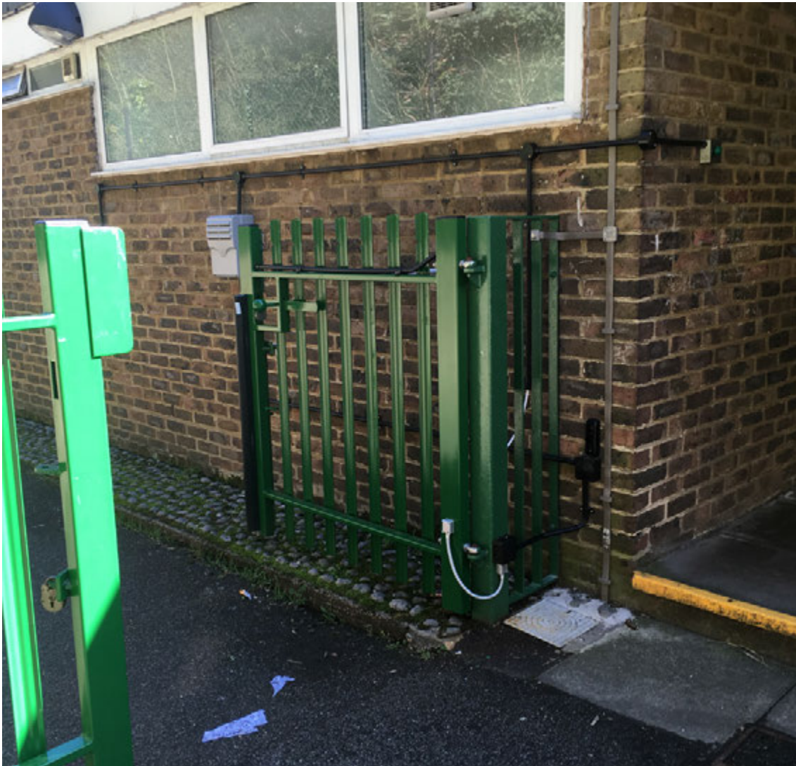
Drei Klemmgefahren in einem. 1: Zwischen Anschlagblech und dem Flügel. 2: Zwischen Scharnierpfosten und Flügel. 3: Zwischen Flügel und Wand.
