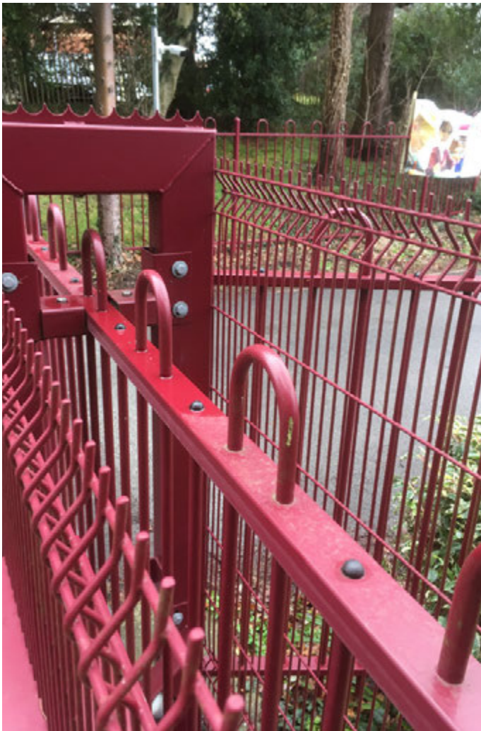
Einzugsgefahr. Die Gittermatten sind nicht hoch genug. Jemand könnte über die Gittermatten greifen – oder versuchen, darüber zu klettern – und in das Führungsportal gezogen werden.
