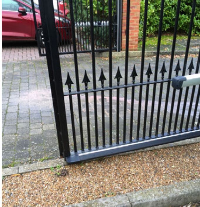
Einhakgefahr. Kleidung könnte sich an den Stabspitzen einhaken und jemand am Flügel mitschleifen.
